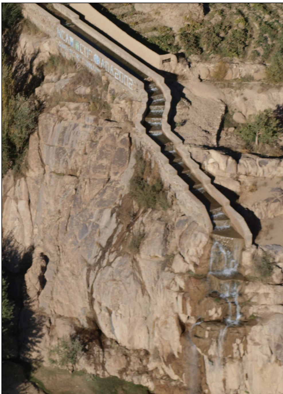
Obr.8 – Detail nedokončené vodní elektrárny.
